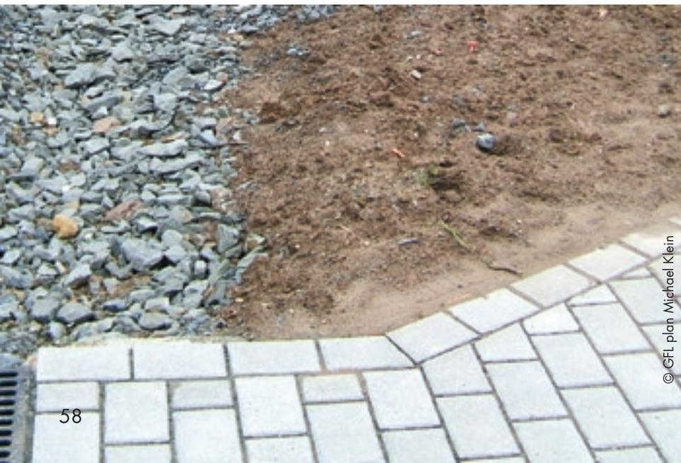
*Einfassung mit einem Pflasterband. Einfassung und Fläche sind mit dem gleichen Stein hergestellt, der Übergang zur Vegetationsfläche ist dadurch harmonischer.*
